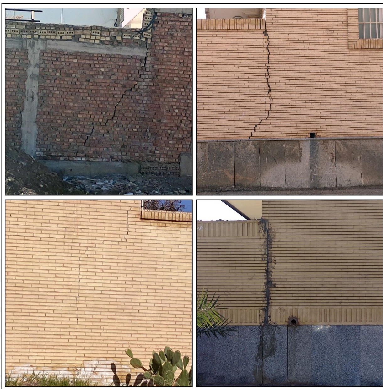
شکل ۵- ترک ها و جدایش های ناشی از فرونشست محلی در محل اتصال محوطه حیاط خانه ها با بخش مسقف و مسکونی.
