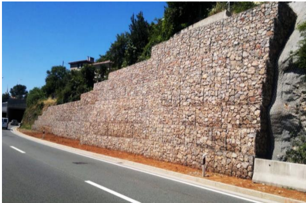
شکل ۱- نمونه‌ای از دیوار حائل گابیونی
