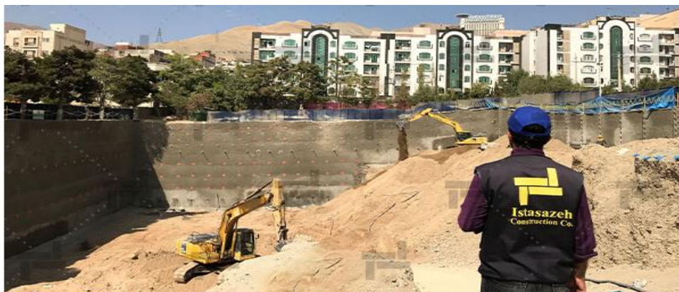
شکل ۱- گودبرداری پروژه مسکونی سایید پارک سعادت آباد
